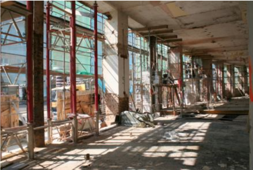
Blick aus dem zukünftigen Eingangsbereich durch die Postplatzfassade zur Bahnhofstraße
