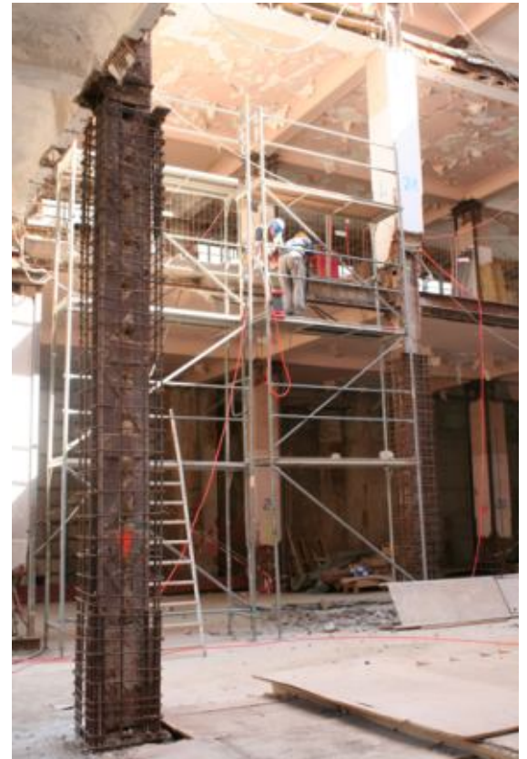
vorbereitende Arbeiten im entkernten Gebäude an der Forststraße für den späteren Einbau der Saaldecke (Tagungssaal)
