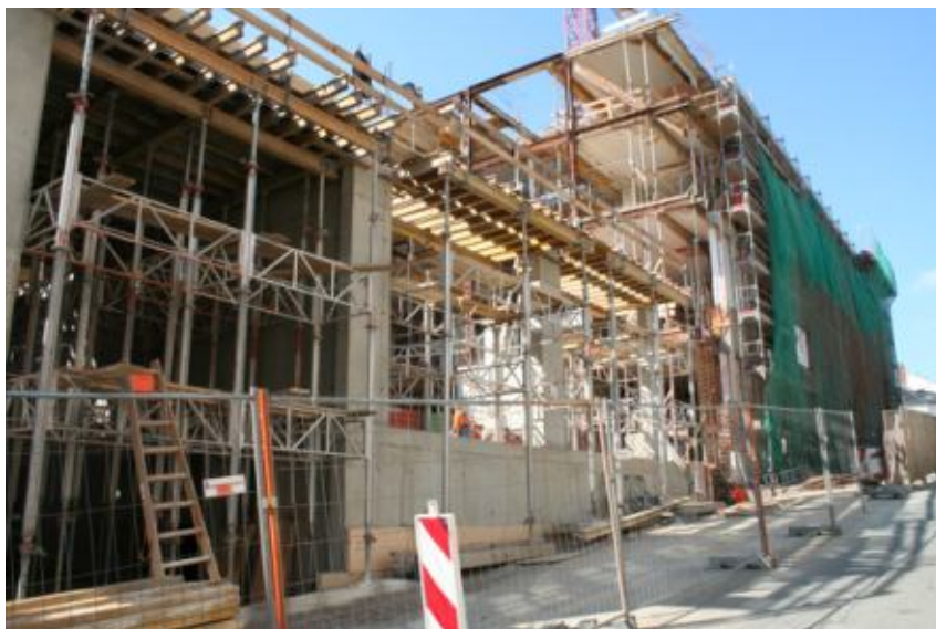
Vorbereitungen zur Fundament-/ Wandbetonage eines Fahrstuhlschachtes im entkernten Gebäude an der Forststraße
