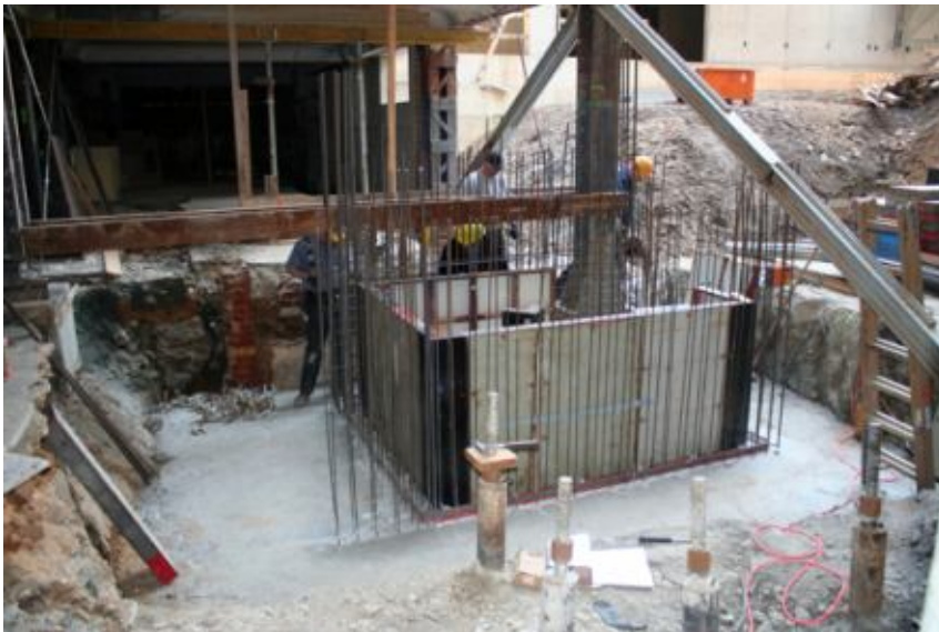
Vorbereitungen zur Fundament-/ Wandbetonage eines Fahrstuhlschachtes im entkernten Gebäude an der Forststraße
